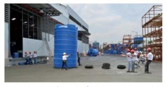
Para levantar el tanque se requieren de mínimo 7 personas en la parte frontal y 2 en la parte posterior. El templador de la parte posterior debe sujetarse en una base firme y gradualmente ir templando hasta ponerlo en posición vertical.
