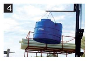
Levante el tanque de los tirantes en sentido vertical, con tecle o polea.
