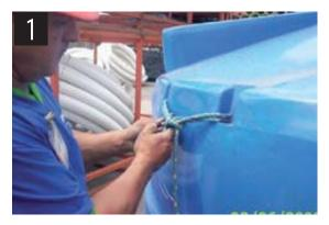
Amarre con un lazo en forma segura la ceja de anclaje del tanque con el cabo. A continuación pase el cabo por debajo del tanque para amarrar la ceja opuesta.
