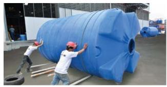
Si es necesario rodar el tanque de un punto a otro, se recomienda utilizar como base tubos o cañas que sirvirán para agilitar el traslado y evitar el contacto directo del tanque con el terreno.
